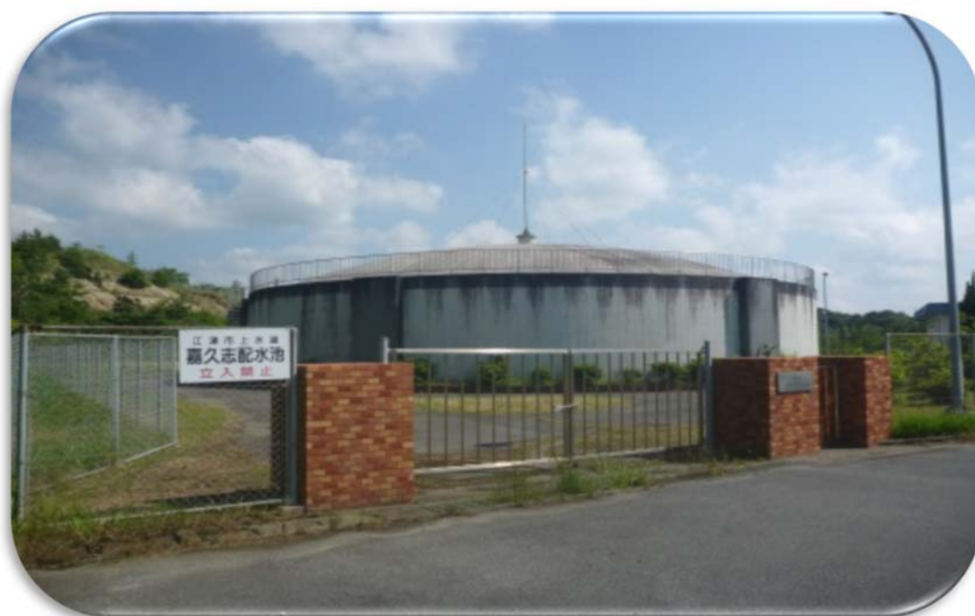
「嘉久志配水池」
