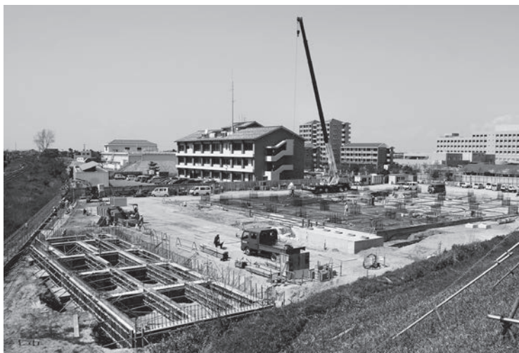
基礎コンクリートの養生をしている付属棟（手前側）と基礎工事を終えた新庁舎本体（奥側）（4月9日撮影）
