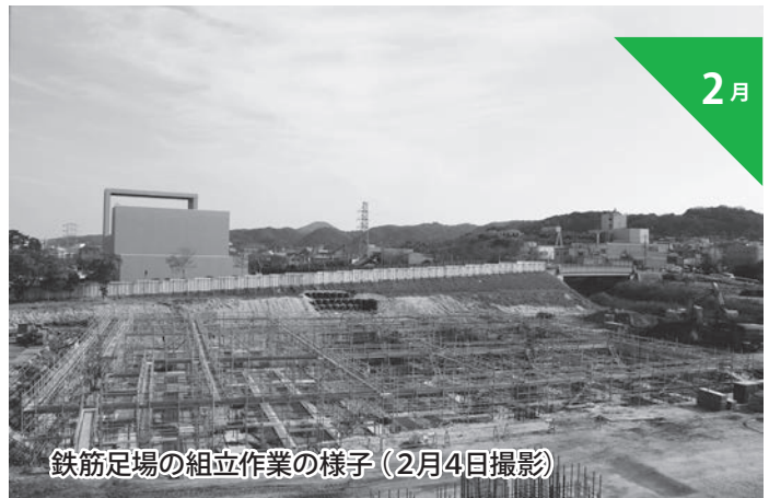
基礎杭の打設作業の様子 (12月13日撮影)
