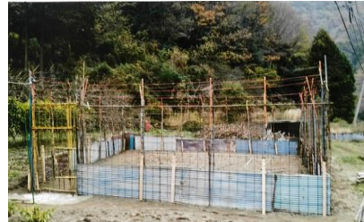
倒壊した防護柵の復旧 (大貫)
