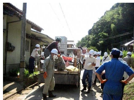
【消防団員による瓦礫撤去作業】
