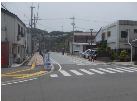
一般県道あけぼの通り線 電線共同溝、舗装工
