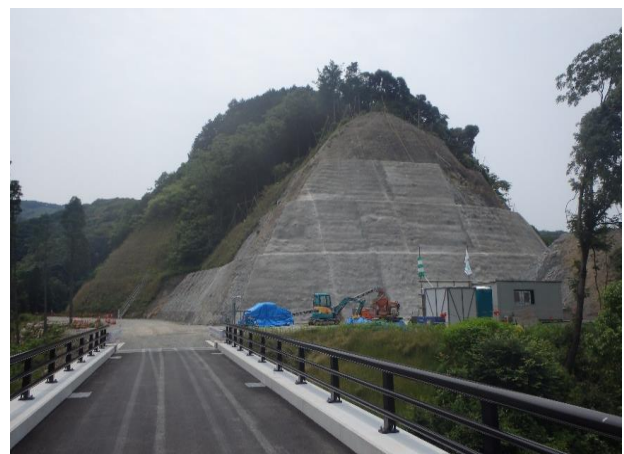
土工1式、法面工1式
