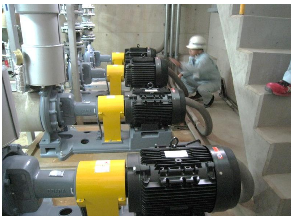
冷温水・冷却水ポンプ改修工事
