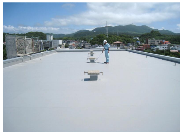
舞台上部屋上防水修繕工事
