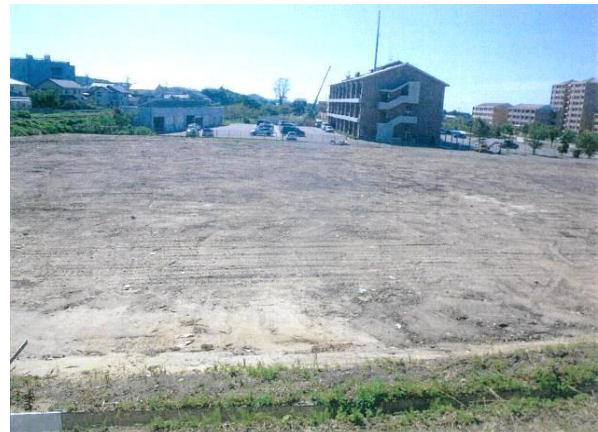
敷地造成工事（完了後）
