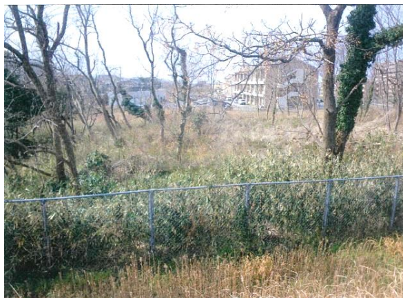
敷地造成工事（着手前）
