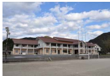
石州赤瓦を使用し、地域景観と調和している校舎
