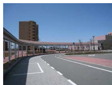
石州赤瓦を使用した歩廊
