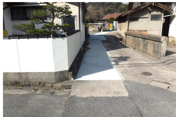
塩田中通線側溝蓋設置工事
