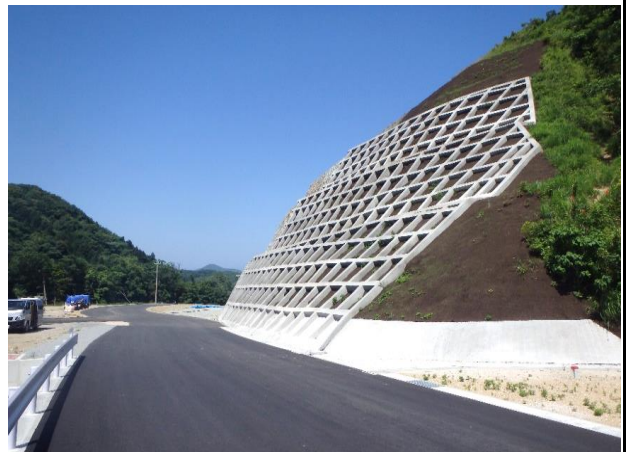
一般県道大田井田江津線 法柁工L=3,700m、植生工A=3,500m 2
