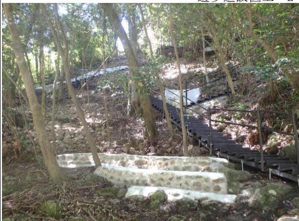
波積ダム周辺整備工事（第1期） 遊歩道設置工 L=47.4m 石積工 A=36m 2
