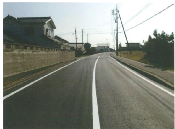
市道江津敬川海岸線舗装整備工事
