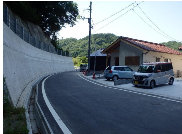
Aブロック上流側
