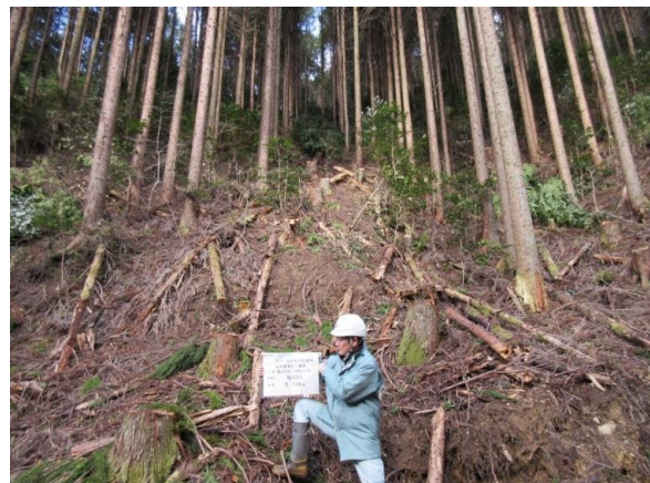
【搬出間伐竣工】
