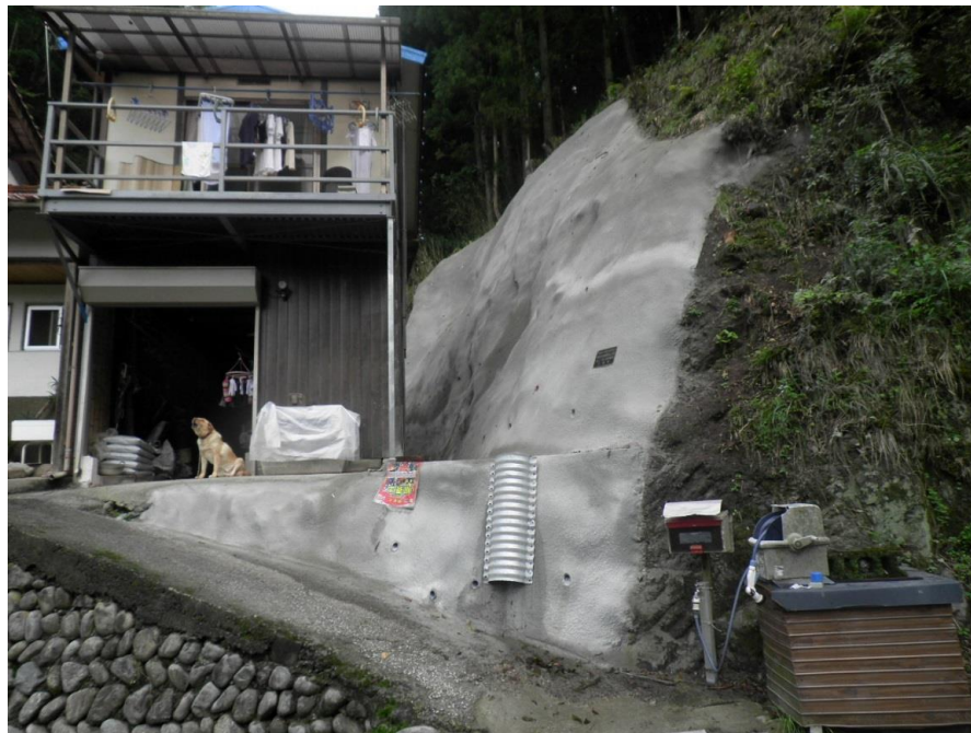
平成27年度（28年災）県単林地崩壊防止工事（山中東）
