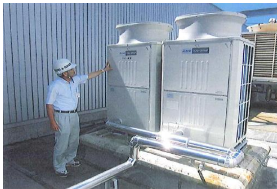
空調設備改修工事(屋上室外機取替)
