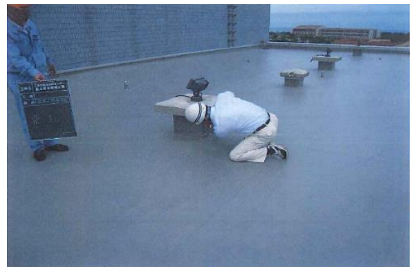
屋根防水修繕工事(客席上部屋根施工後)
