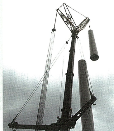
風車を組み立てている様子
