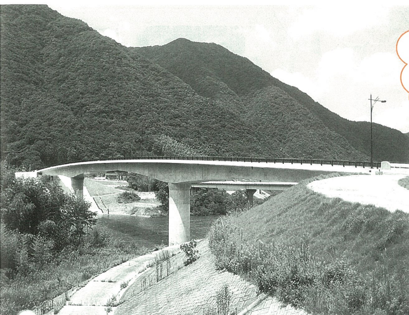
▲平成19年度に完成した渡田大貫線の川越大橋。平成20年度には、向こうに見える旧橋の撤去工事が予定されているが。
