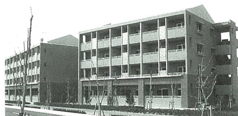
▲平成20年2月に完成したシビックセンターの市営住宅「江津中央団地」2号棟。平成20年度は、北側隣接地に建つ9階建てに着工の予定。
