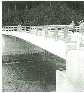
山中線道路改良（舞立橋）
