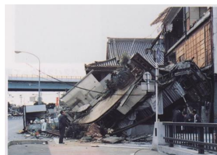
▲阪神・淡路大震災による住宅の倒壊
