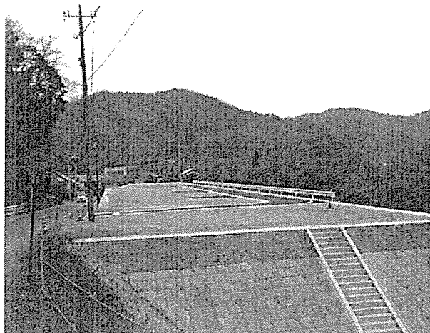
Bブロック完成写真
