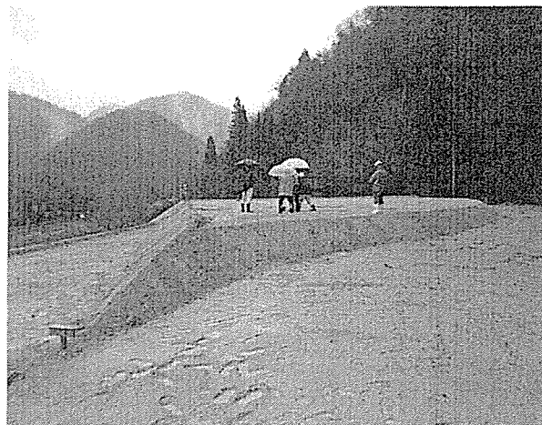
Aブロック施工中写真
