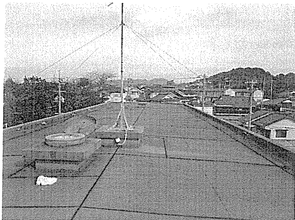
【防水改修施工前】
