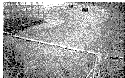
③高角小校地西側側溝
