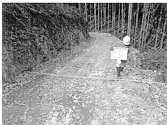
【路盤の補強：邑智郡森林組合】
