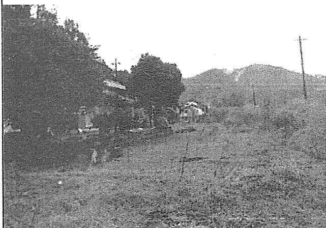
家屋解体着工前
