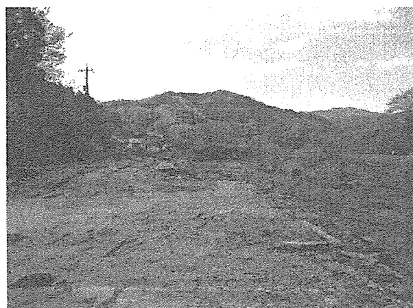
家屋解体完了
