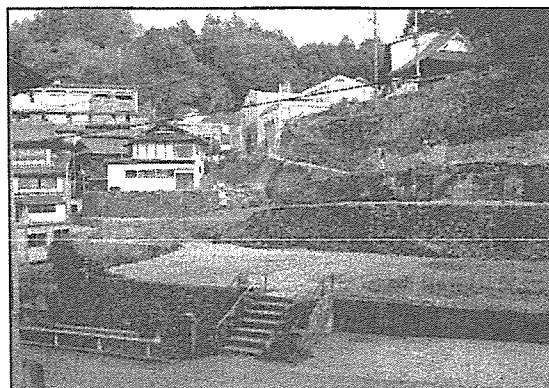
火災跡地現況
