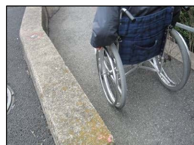
【国道9号 江津跨線橋】 ・歩道の幅員が狭い
