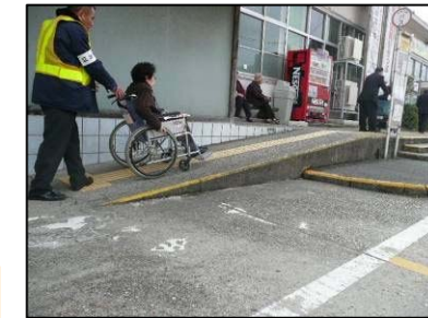
【江津駅前】 ・スロープの傾斜が急
