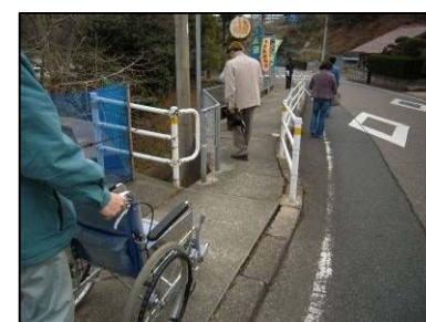
【県道 江津三次線】 ・白線が消えている
