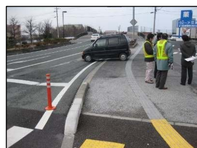
【市道 高丸線】 ・点字ブロックの統一性が無い
