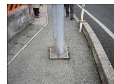
【国道9号】 ・歩道の障害物
