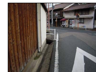
【市道 渡津本町線】 ・歩道が確保されていない
