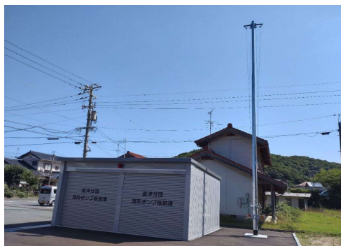
渡津分団消防ポンプ格納庫・乾燥塔整備
