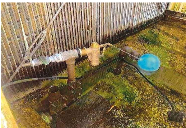
冷却塔ボールタップ（自動給水弁）取替
