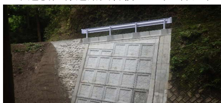
市道後山線道路災害復旧工事（竣工）
