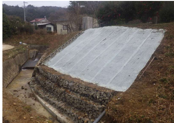
千田川護岸修繕
