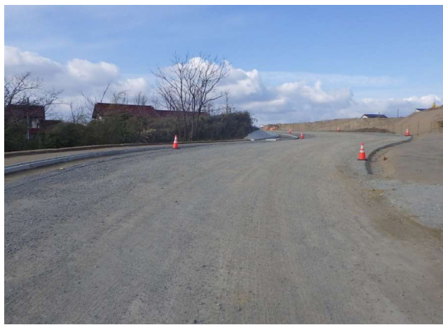
市道赤羽根団地8号線道路改良工事（竣工）
