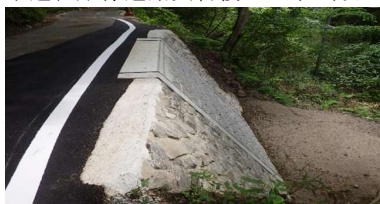
市道笹畑線道路災害復旧工事（竣工）
