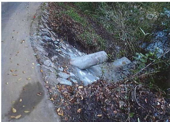
市道上津井線暗渠修繕
