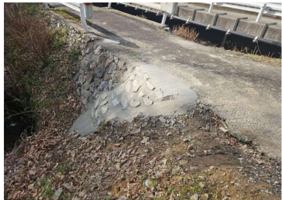
市道久保川2号線路肩修繕
