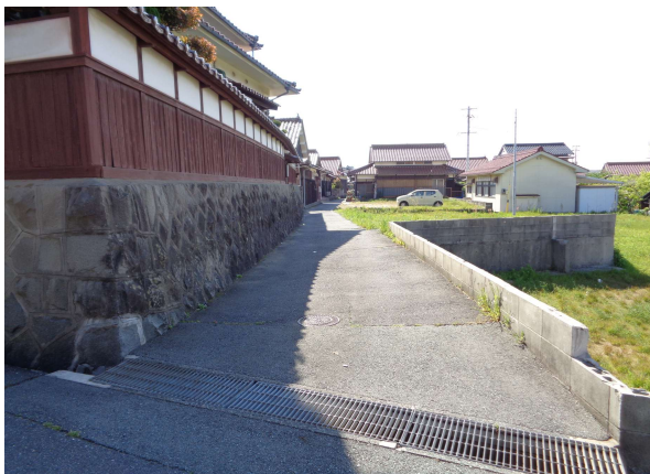
市道都野津110号線（整備前）
