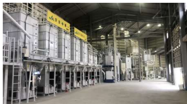
江津市乾燥調製施設 機械器具（乾燥機、粳擦機、計量出荷施設他）設置
