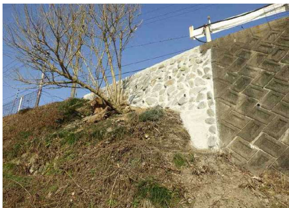
市道市山長谷線石積修繕
