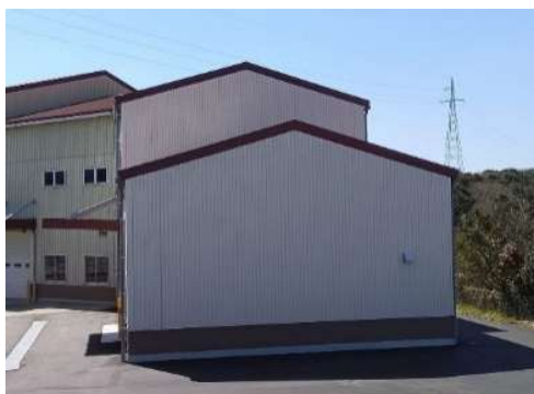
江津市乾燥調製施設 建屋増築（233㎡）
