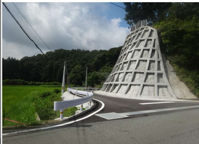
市道下都治線交通安全対策工事（竣工）
