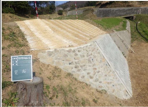
復旧完了写真
