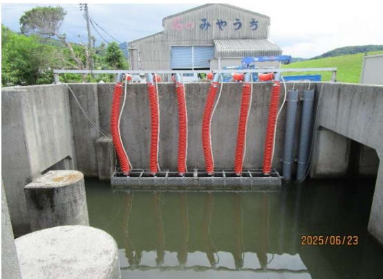
10号都市下水路排水ポンプ設置（竣工）
