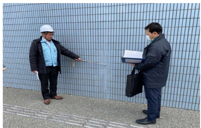
外壁診断検査
