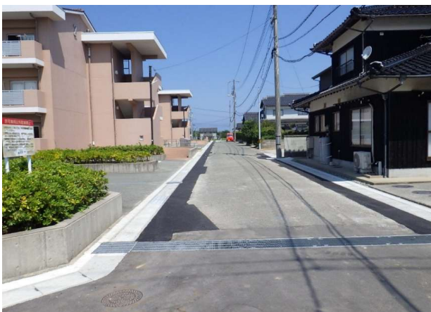
市道敬川東沖の浜4号線側溝改良工事（竣工）
