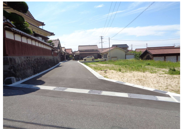
市道都野津110号線（整備後）
