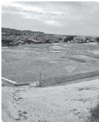
建設中の青陵小学校
