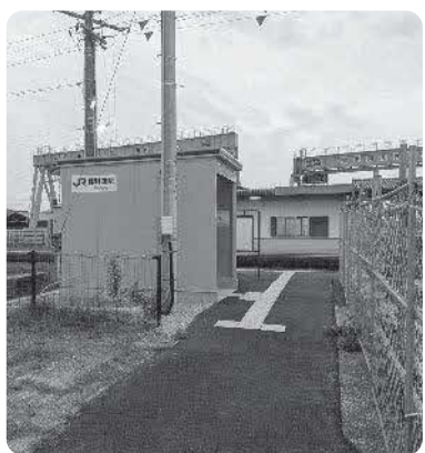
JR都野津駅・仮駅舎
