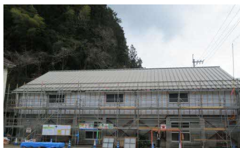
壁はり・窓取り付け
