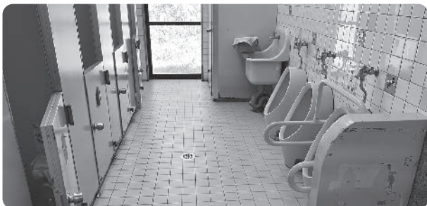
改修予定の「さくらこども園」トイレ
