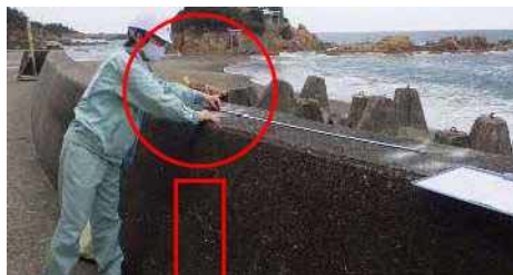
削孔間隔を確認している状況写真
