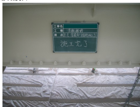
写真 4-2 当て板補強工
