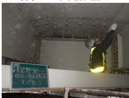
写真 4-4 ひび割れ注入工
