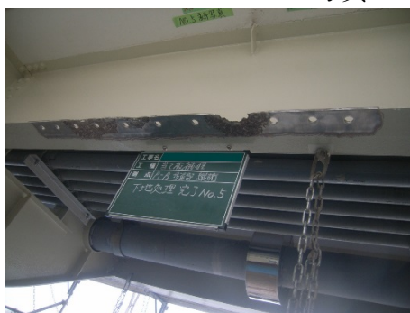
写真 4-2 当て板補強工
