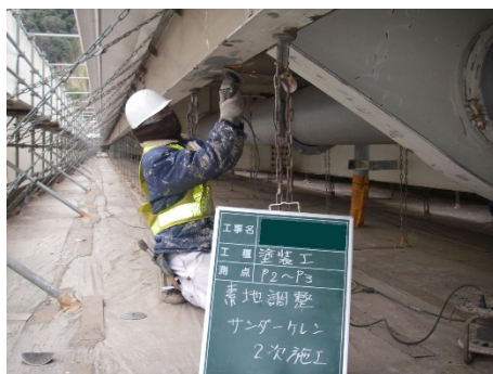
写真 4-1 塗装塗替工
