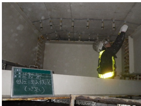
写真 4-4 ひび割れ注入工
