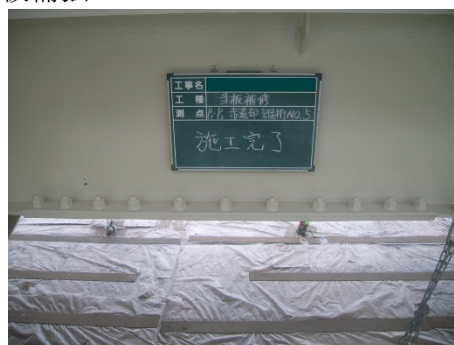
写真 4-2 当て板補強工
