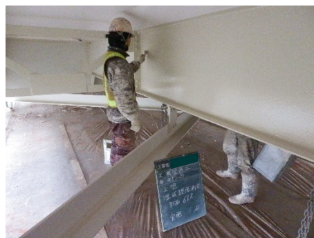
写真 4-1 塗装塗替工
