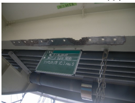
写真 4-2 当て板補強工
