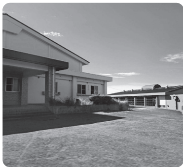
市民体育館・第2体育館
