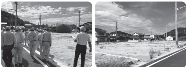
造成が完了した嘉戸団地
