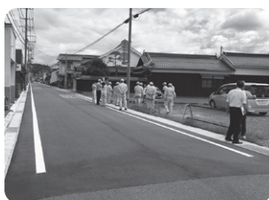
側溝改良工事 (市道都野津敬川中央線)
