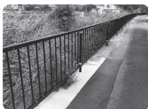
転落防止柵設置工事 (市道江津駅裏線)
