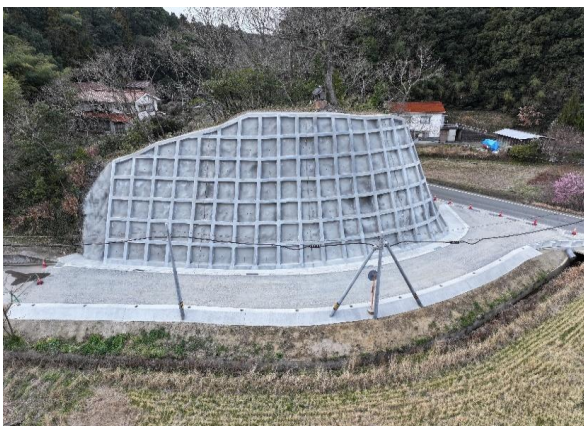
市道下都治線落石対策工事（竣工）
