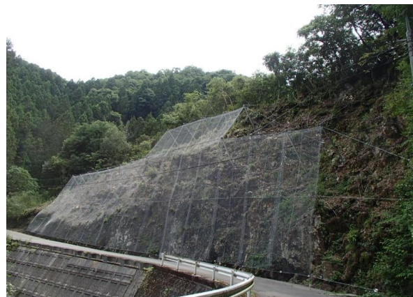
市道川平平床線落石対策工事（竣工）
