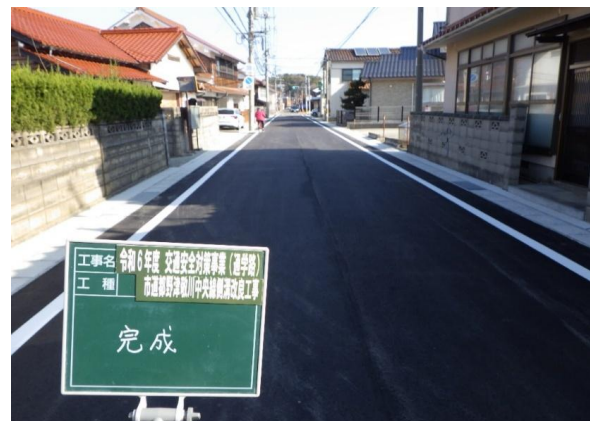
市道都野津敬川中央線側溝改良工事（竣工）
