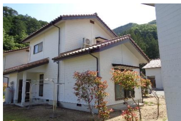
定住促進長尾団地外壁塗替他工事
