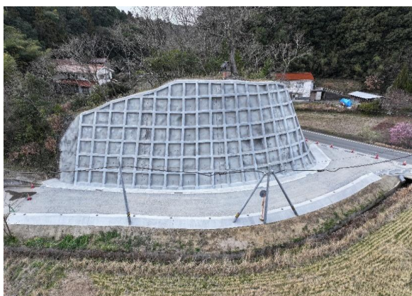
市道下都治線落石対策工事（竣工）
