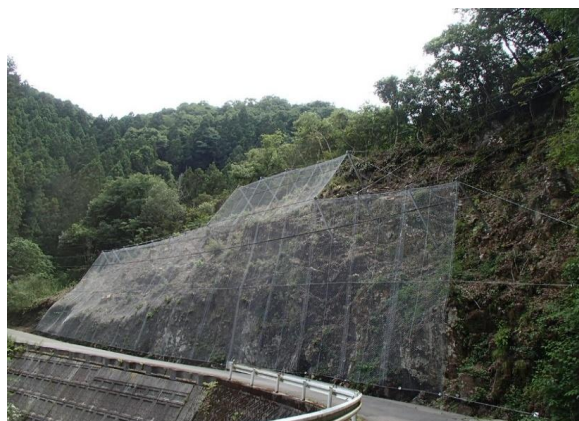
市道川平平床線落石対策工事（竣工）
