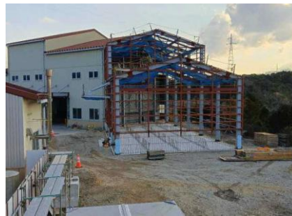
着工後 R7.1.24 増築等 鉄骨建方
