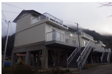
市営住宅養路団地外壁改修他工事
