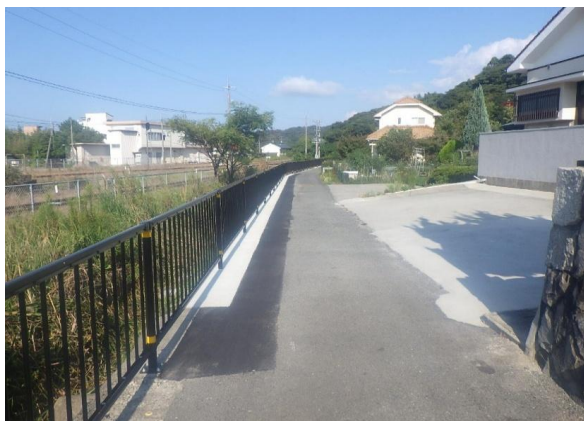
市道江津駅裏線転落防止柵設置工事（竣工）
