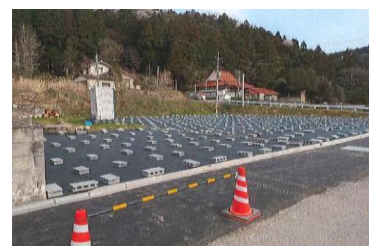
市営住宅小田団地及び小田住宅解体工事
