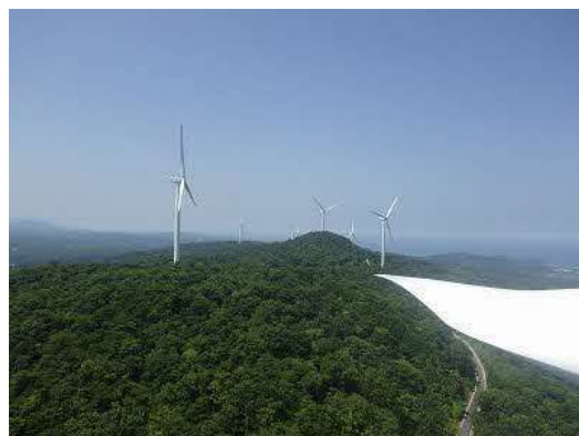
図22. 島根県「江津高野山風力発電所」
