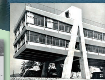
江津市庁舎完成 1962 年 (昭和 37 年)
