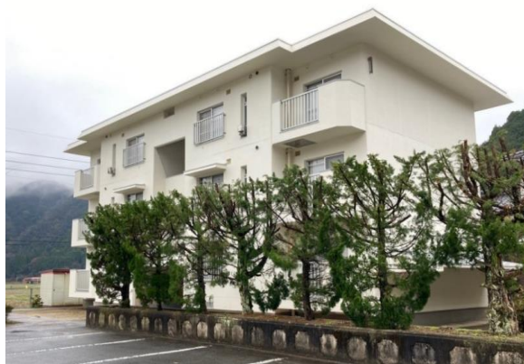
市営住宅今田1号棟団地外壁改修工事(竣工)
