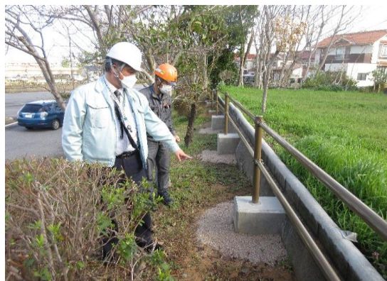
境地へのガードパイプ設置工事
