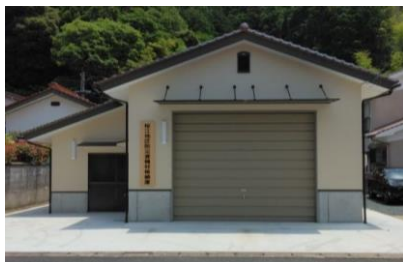
桜江地区防災資機材格納庫
