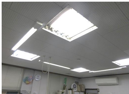
事務室照明器具更新
