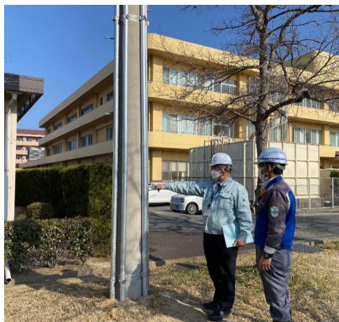
光回線回路構築工事
