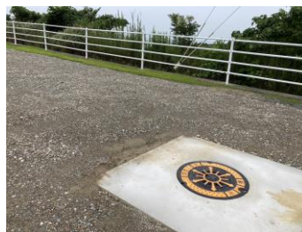
防火水槽（島の星町）
