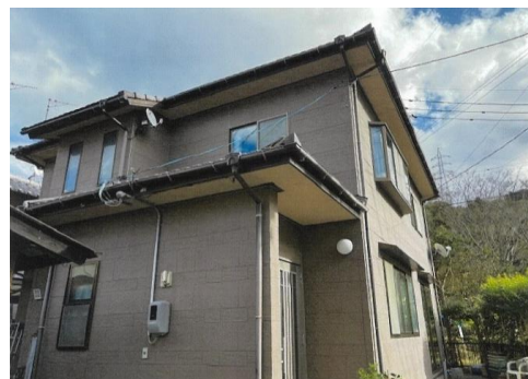
外壁修景（着手前）
