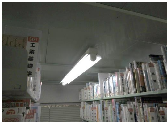
子ども室・一般室照明器具更新
