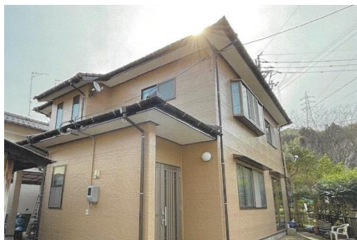
外壁修景（着手後）
