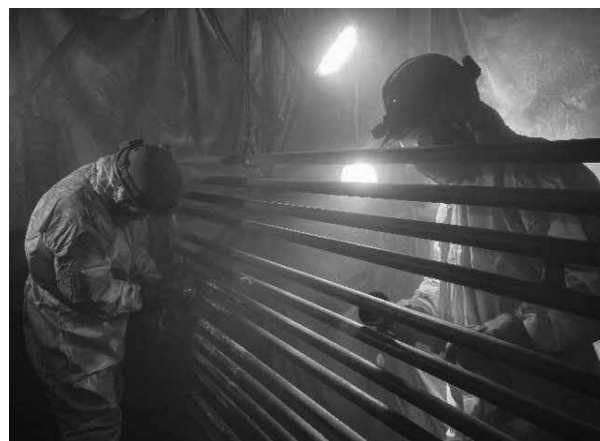
▲ボイラ水平蒸発管更新
