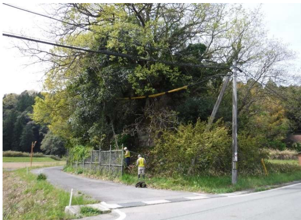
市道下都治線落石対策測量設計業務 現況写真
