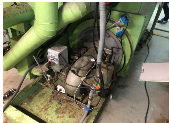
1階給気ファン更新工事
