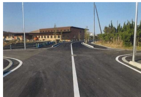
蛭子北道路新設舗装工事
