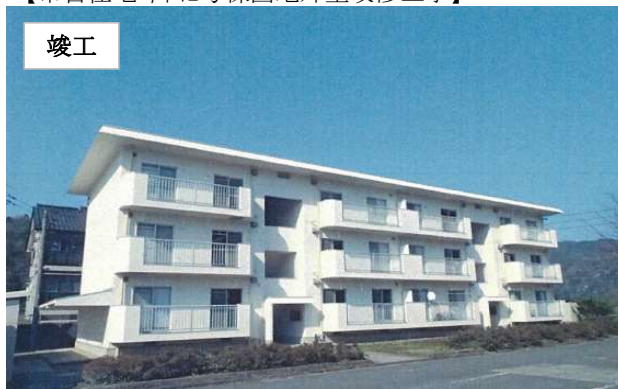
【市営住宅今田2号棟団地外壁改修工事】
