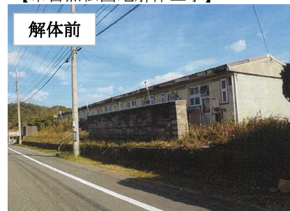
【市営黒松団地解体工事】
