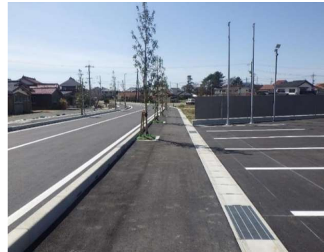
蛭子北道路新設工事
