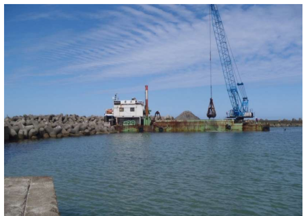
【泊地浚渫状況】
