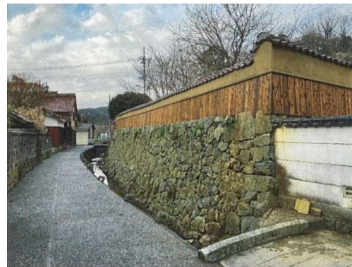
修景（土塀修景）
