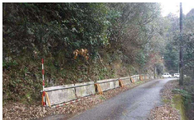
市道川平平床線落石対策測量設計業務 現況写真
