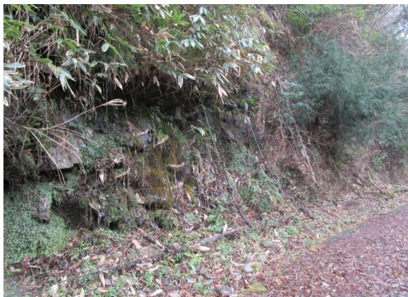
市道戸川川下線法面補修測量業務 現況写真
