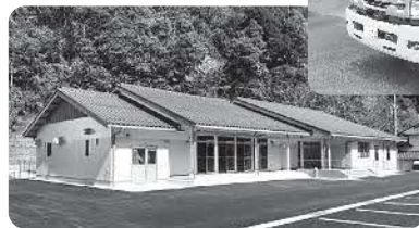
川越地域コミュニティ交流センター・防災拠点施設
