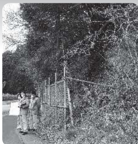
落石対策工事予定の市道下都治線
