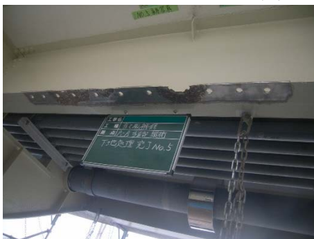
写真 4-2 当て板補強工
