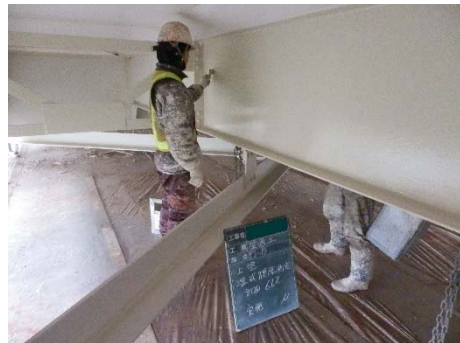
写真 4-1 塗装塗替工
