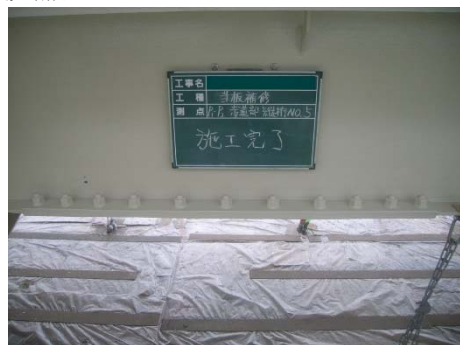
写真 4-2 当て板補強工
