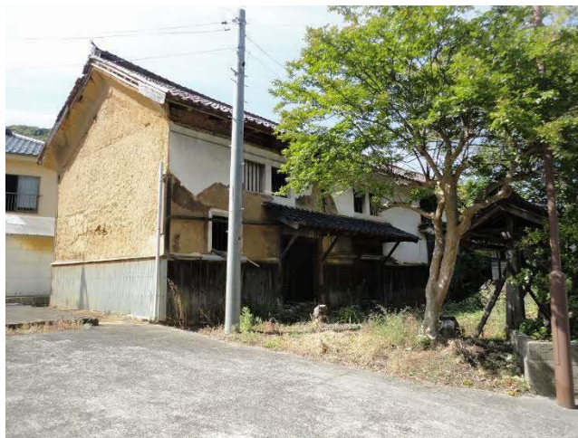
写真 左)天領江津本町藁街道にも放置された空家が見られます
