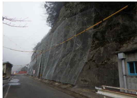
市道戸川川下線災害防除工事
