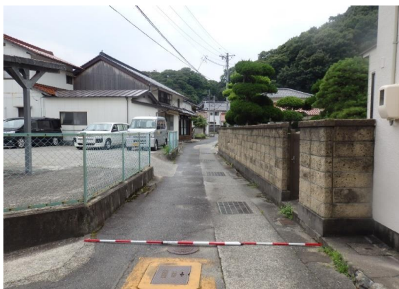
本町裏通線（整備前）
