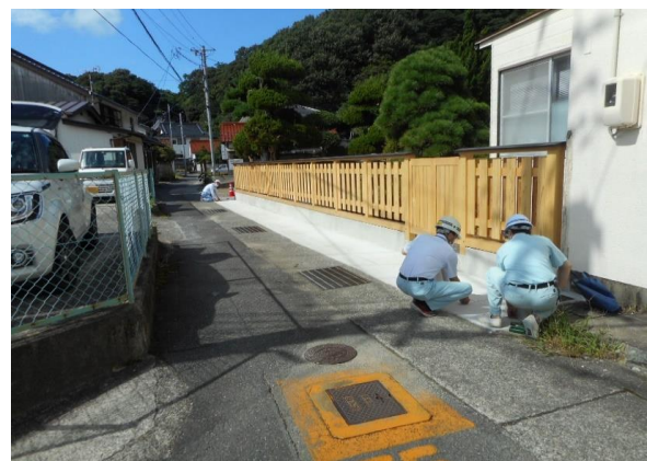
本町裏通線（整備後）
