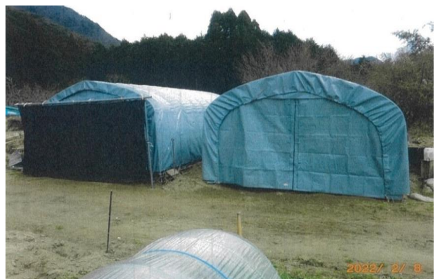
農地及び農業用施設等災害復旧対策事業 ・再建した農業用ハウス
