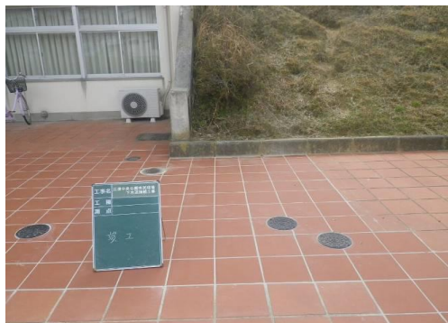
市民球場トイレ下水道接続工事
