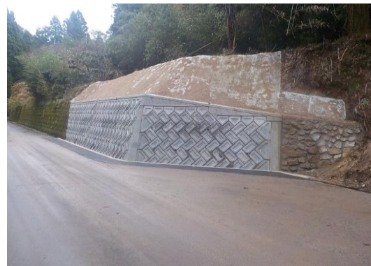
市道上津井線擁壁補修工事
