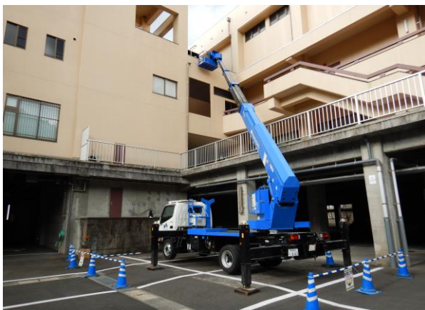
桜江総合センター屋外機械置場樋改修作業
