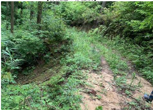
【作業道の修繕前】
