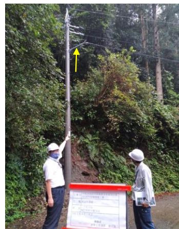
修繕後（復旧電柱に添架）
