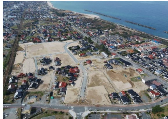
施工状況 (R4.3月現在)
