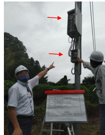
修繕後（機器交換）
