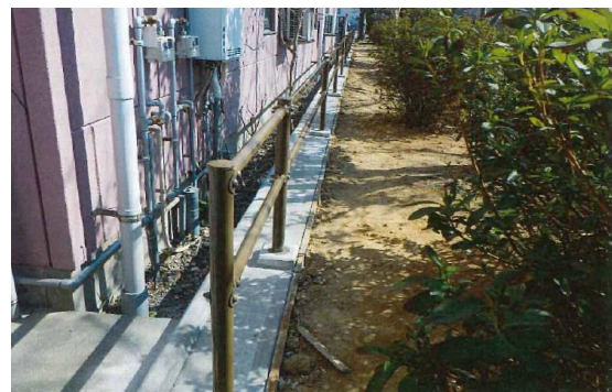
ブロック塀撤去及びガードパイプ設置工事
