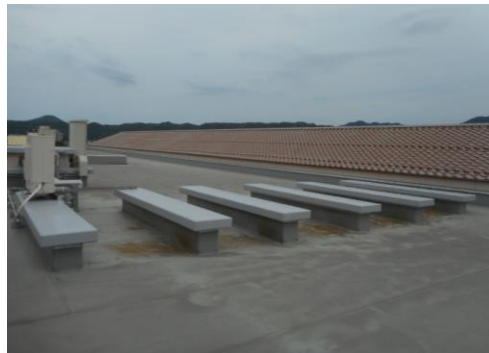
(室外機撤去後)
