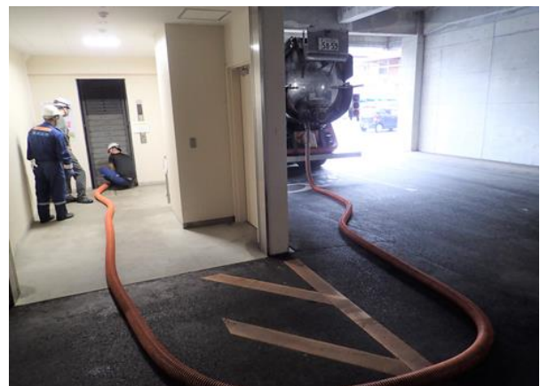
桜江総合センター1階エレベータ内水の排水作業
