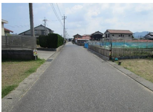
市道敬川大浜線（現況）
