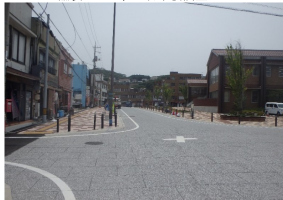
県道あけぼの通り線 舗装工一式、建物事後調査一式
