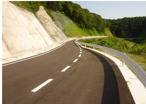
付替え林道 土工・法面工
