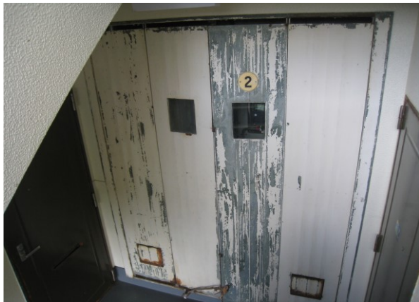
浅利曙団地1・2号棟PS建具取替前
