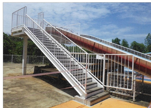
徒渉プール階段取替工事
