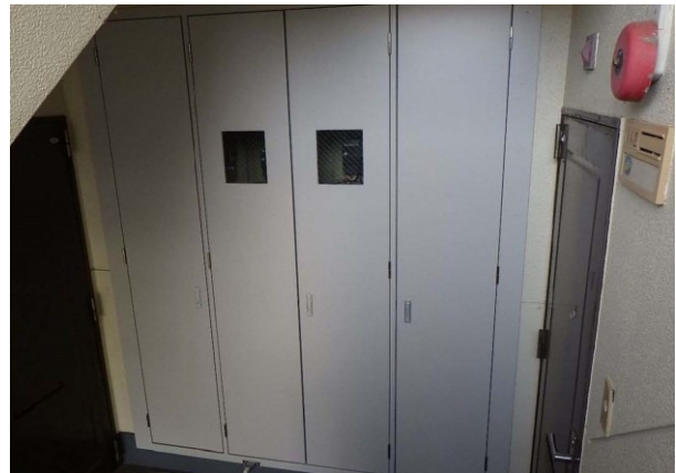
浅利曙団地1・2号棟PS建具取替後
