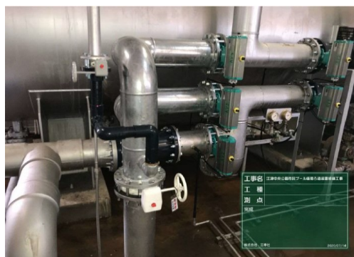
市民プール循環ろ過装置修繕工事
