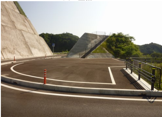
付替え林道 周辺整備
