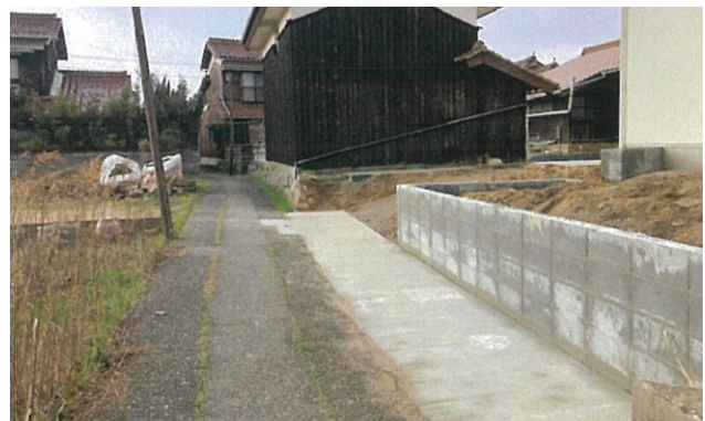
都野津30号線（整備後）
