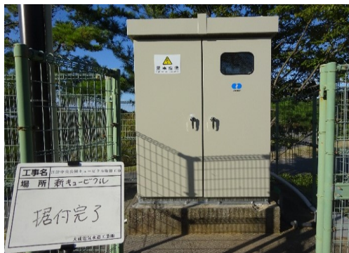
キュービクル取替工事
