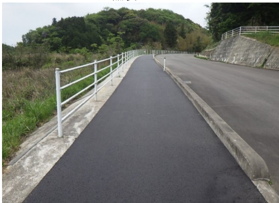
県道田所国府線 舗装工一式
