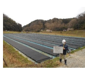
農業法人B ・灌水設備設置
