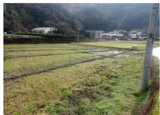
暗渠排水工事完了
