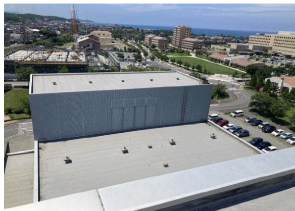
江津市教育施設庁寿命化計画に係る外壁点検 (市民センター屋上より)
