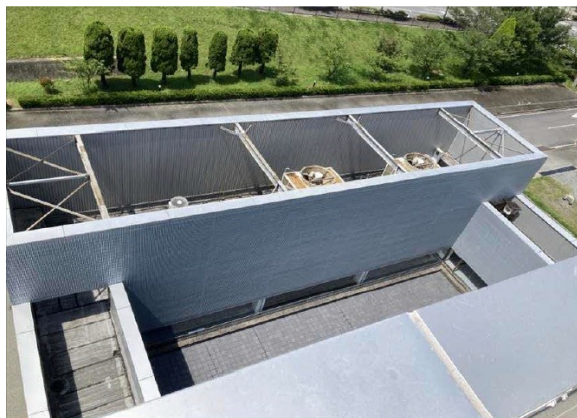
建築基準法第12条に係る点検 (市民センター屋上より)
