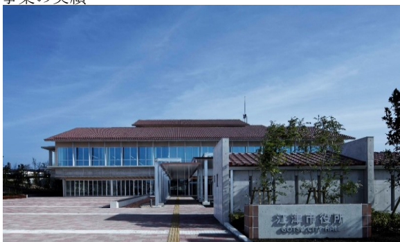
完成写真 (庁舎棟)
