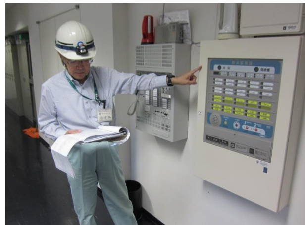
火災報知器・非常放送設備取替工事
