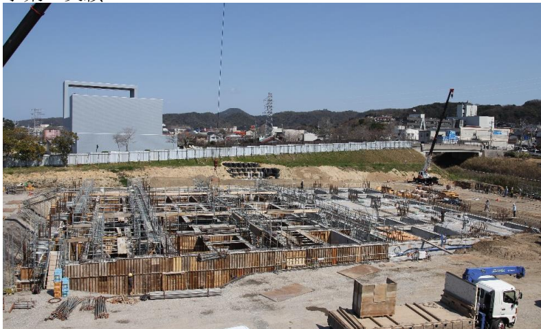
庁舎新築工事（基礎工事）
