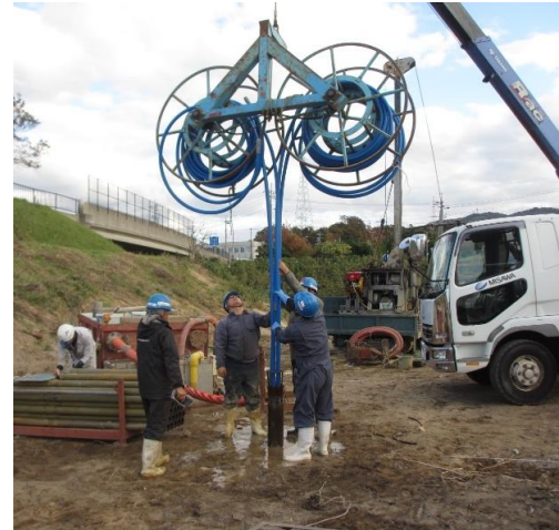
地中熱利用設備工事（熱交換器挿入作業）
