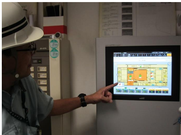
中央監視装置更新工事
