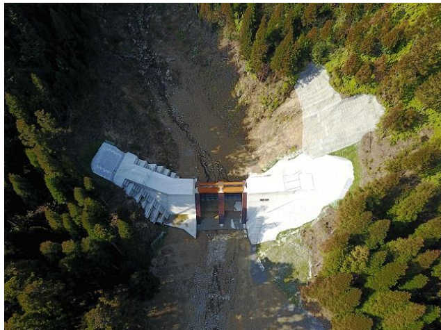
①砂防 畑ヶ谷川砂防堰堤
