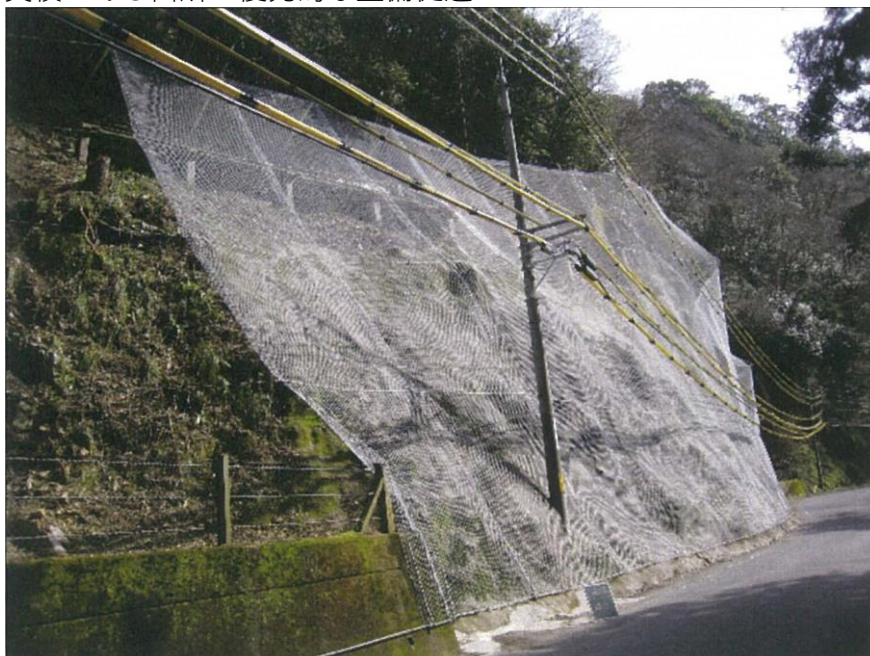
市道戸川川下線災害防除工事
