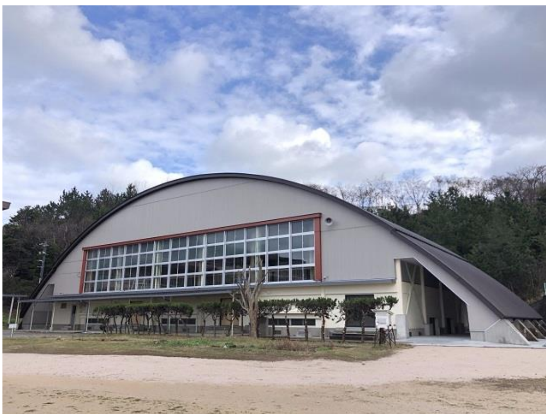
渡津小学校屋内運動場耐震化
