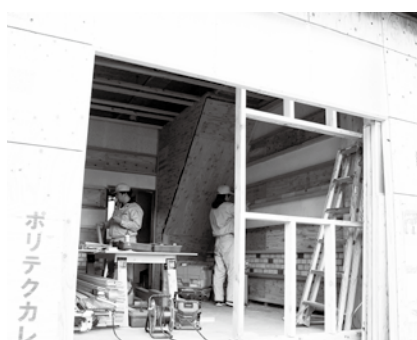
↑12月18日、作業が進み、内装が徐々に出来上がってきました。
