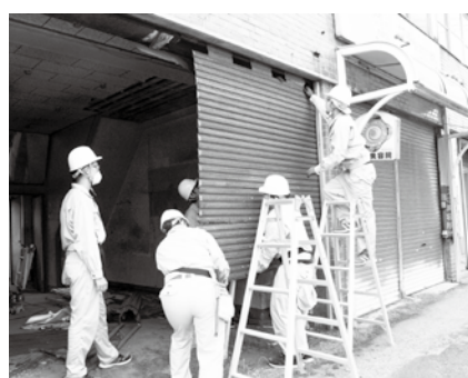
↑6月27日、外装や天井などを解体・撤去しました。
