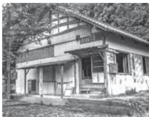
災害で使用不能となった渡田自治会館
