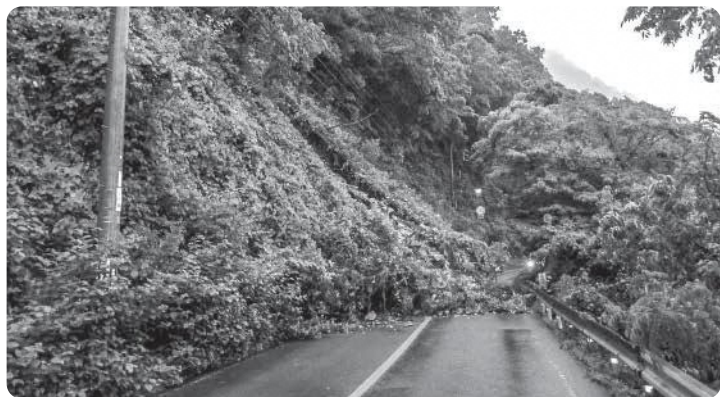
5月7日に崩落した国道261号線の現場
