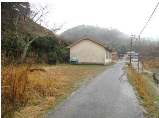
井沢清見会館解体工事施工前
