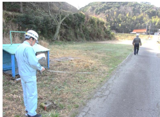
井沢清見会館解体工事施工後
