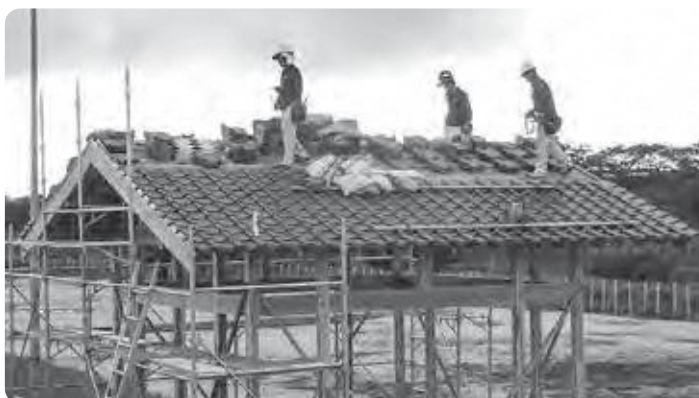
熊本地震後の益城町で石州瓦が用いられて建設中の神楽舞台
