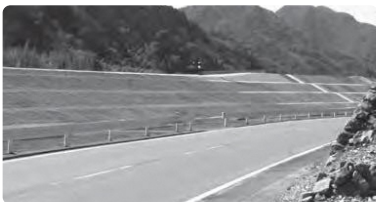
平成29年度で暫定的整備完了の大貫堤防
